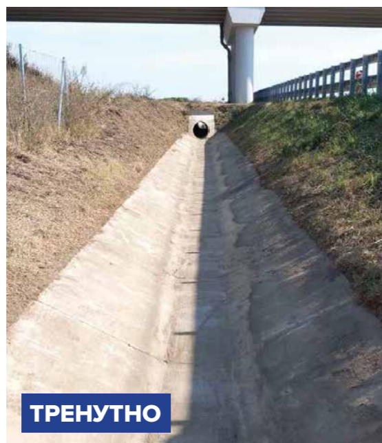
РЕХАБИЛИТАЦИЈА СИСТЕМА ЗА ОДВОДЊАВАЊЕ ПОВРШИНА КОЛОВОЗА НА ДРЖАВНИМ ПУТЕВИМА ШИРОМ ВОЈВОДИНЕ
