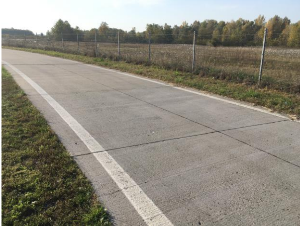
Слика 4.1.20. Постојећи бетонски коловоз на теретном терминалу
