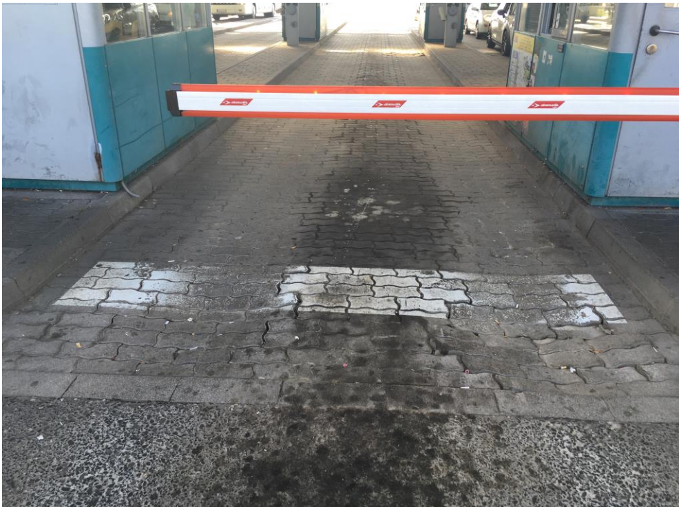
Слика 4.1.29. Колотрази на траци за путничка возила
