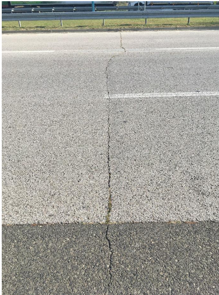
Слика 4.1.33. Попречна пукотина
