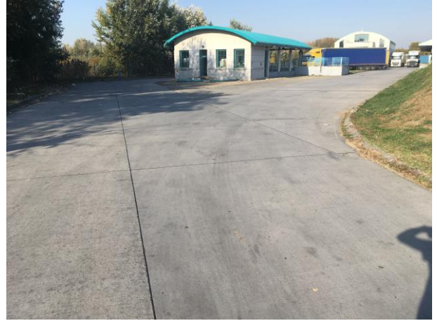
Слика 4.1.21. Постојећи бетонски коловоз на теретном терминалу
