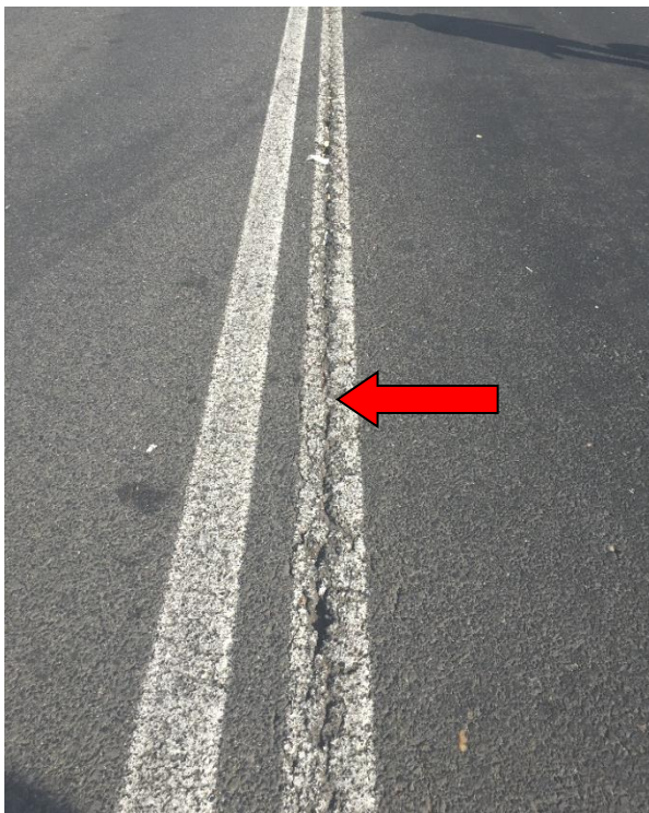
Слика 4.1.1. Подужни шлус између траке за теретна и путничка возила
