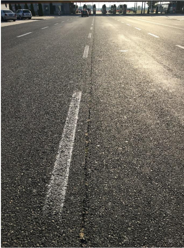
Слика 4.1.24. Подужна пукотина – лоше изведен „шлус“
