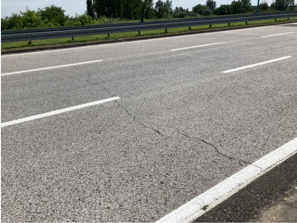
Слика 4.1.32. Попречна пукотина
