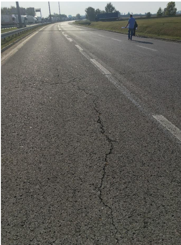
Слика 4.1.30. Подужна и попречна пукотина
