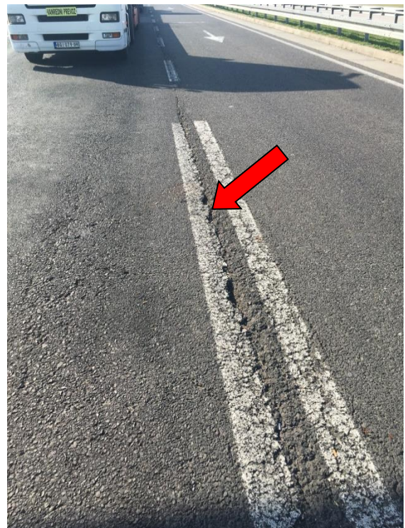
Слика 4.1.2. Подужни шлус између возне и претицајне траке
