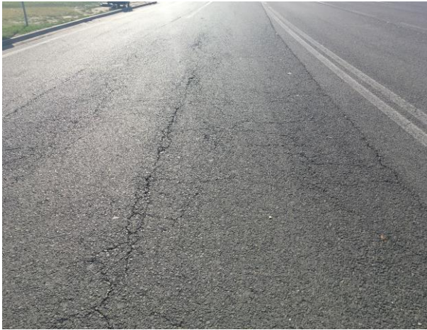
Слика 4.1.17 Пукотине на траци за аутобусе
