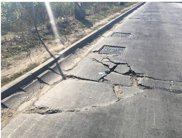
Слика 4.1.11. Лом бетонске плоче у углу
