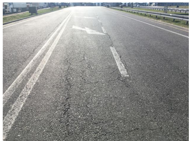
Слика 4.1.16. Експанзија подужних пукотина и појава попречних пукотина између њих
