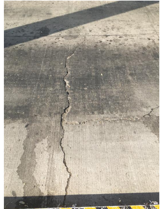
Слика 4.1.10. Пукотина по средини бетонске плоче
