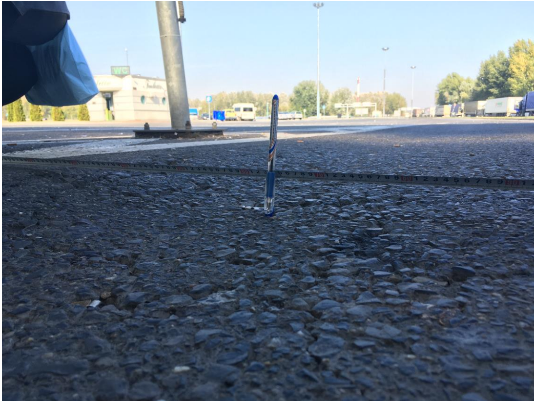
Слика 4.1.8. Колотрази у зони царинско - пасошке контроле
