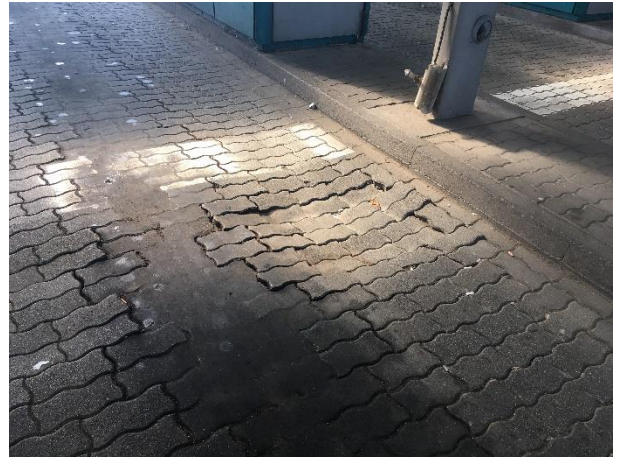
Слика 4.1.14. Улегнуће на терминалу за путничка возила. Плоче су улегле, одвојене и „лабаве“
