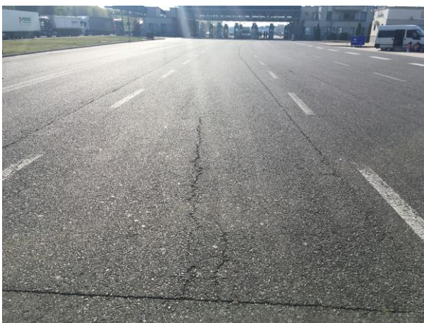
Слика 4.1.15. Подужне пукотине и слабо одрађени подужни спојеви
