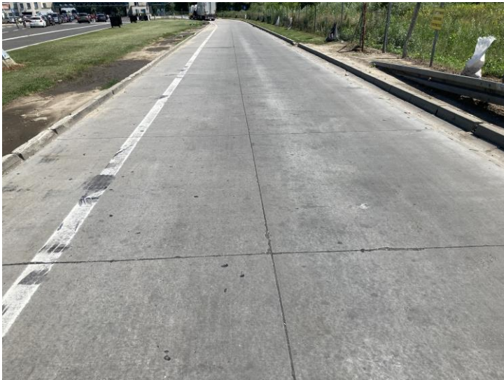
Слика 4.1.9. Бетонска плоча без оштећења
