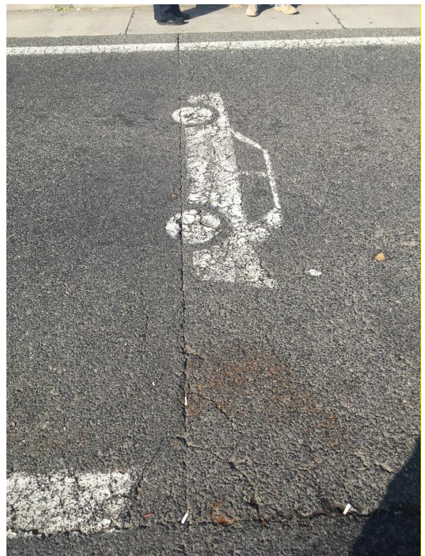
Слика 4.1.7. Попречна пукотина – радни спој претицајне траке
