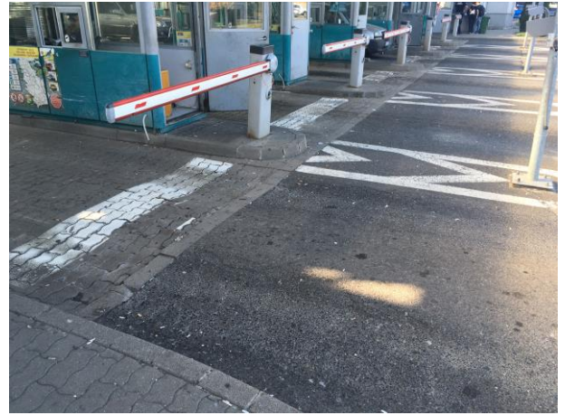
Слика 4.1.18 Колотрази на асфалту непосредно после царинско-пасошке контроле на терминалу за аутобусе
