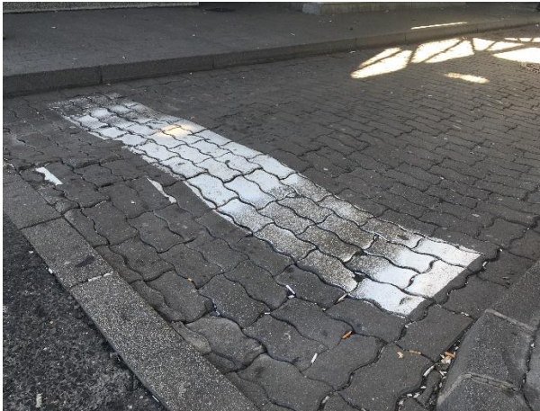
Слика 4.1.13. Колотрази на терминалу намењеном аутобуском саобраћају
