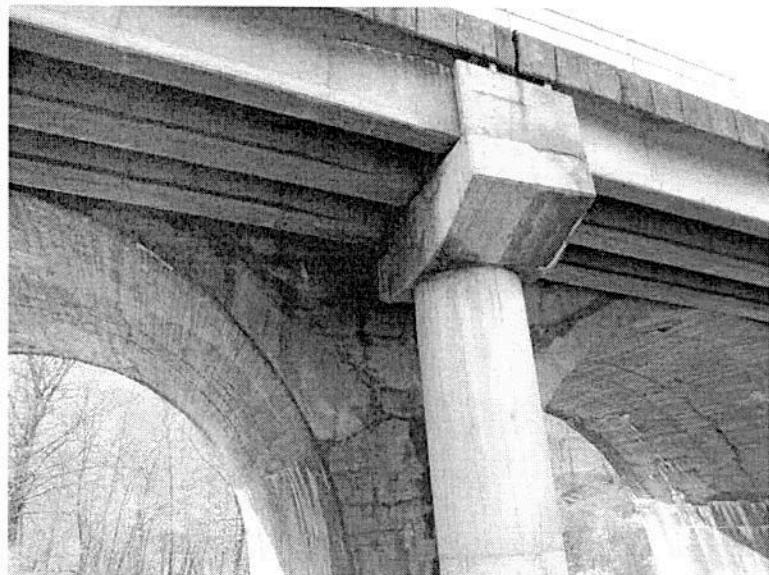
Пропао подужни спој старе и нове конструкције. Стара конструкција је засведена бетонска конструкција. Виде се трагови ранијих поправки процуривања воде али има и нових места процуривање воде. На темељима се не виде пукотине. Ограда на ревизионој стази неадекватна према новим прописима. Треба проверити лежишта на проширенују конструкцији. Према изјави надзорног органа има пројекат поправке објекта.
