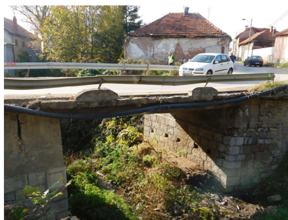
Слика 04: Поглед на мост са низводне стране (слика лево) и са узводне стране (слика десно). Непостојање пешачких стаза. Конзолни делови су оштећени целом дужином са узводне и низводне стране. Огољена арматура захваћена корозијом. Деградирана веза стубића оgrade са конзолним деловима.
