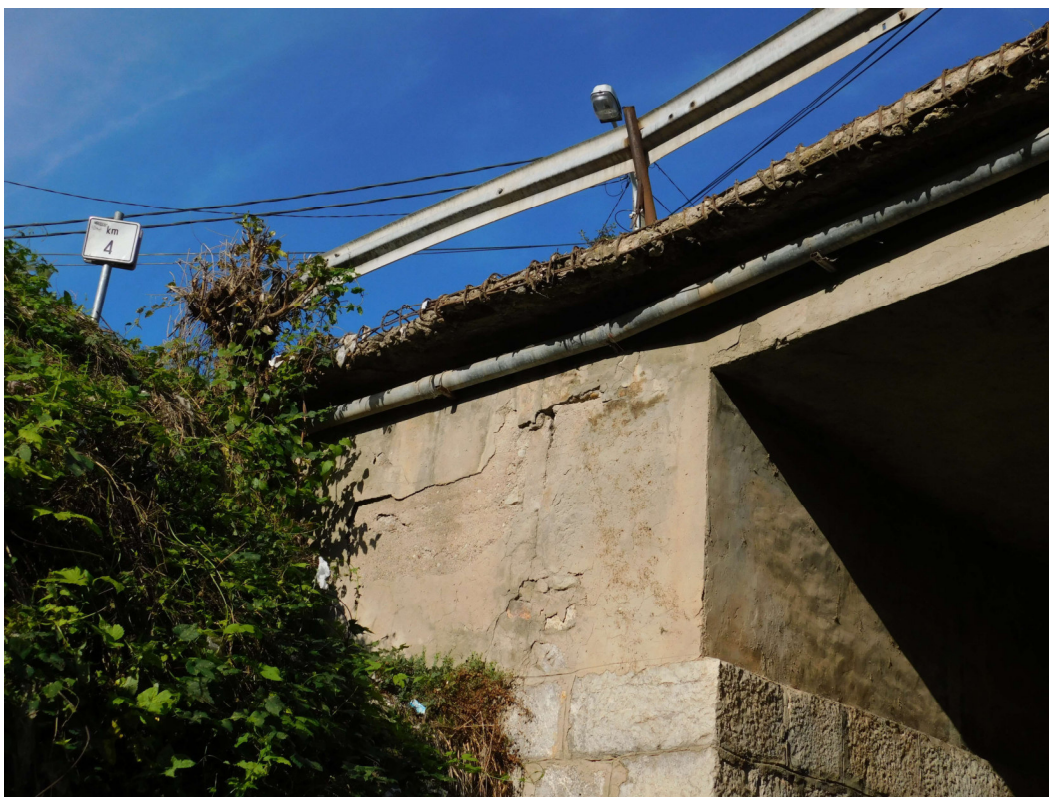
Слика 06: Поглед са низводне стране, стуб на страни ка Нишу. Уочене вертикалне прслине у горњем делу стуба са узводне стране.
