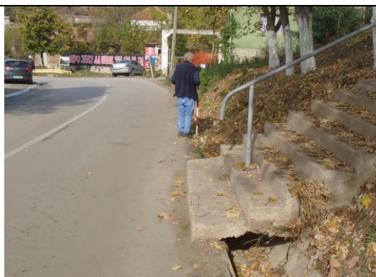
Слика 10 – Степенице изнад одводног канала воде право на коловоз!
