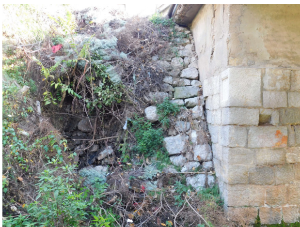
Слика 10: Поглед са узводне стране, стубови на страни ка Кнез Селу (слика лево) и ка Нишу (слика десно). Кегле су оштећене, запуштене и обрасле вегетацијом.
