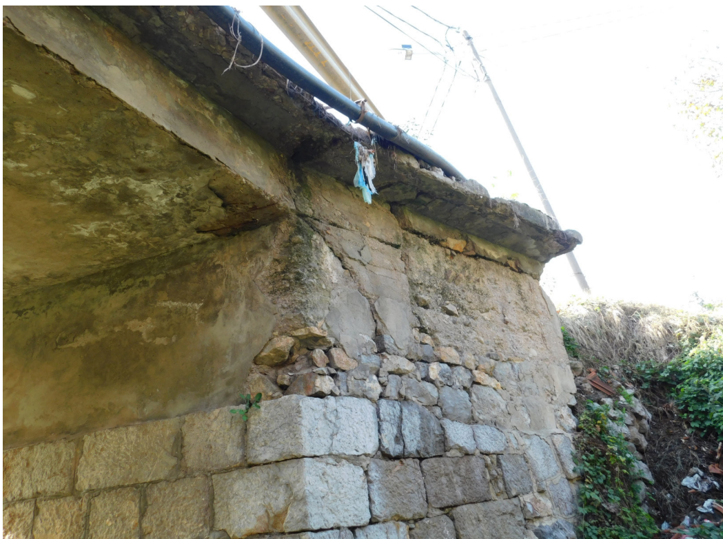
Слика 05: Поглед са узводне стране, стуб на страни ка Нишу. Уочене вертикалне и косе прслине у горњем делу стуба са узводне стране. Видљиве су зоне калцификације и оштећења слоја малтера у надограђеном делу стуба.
