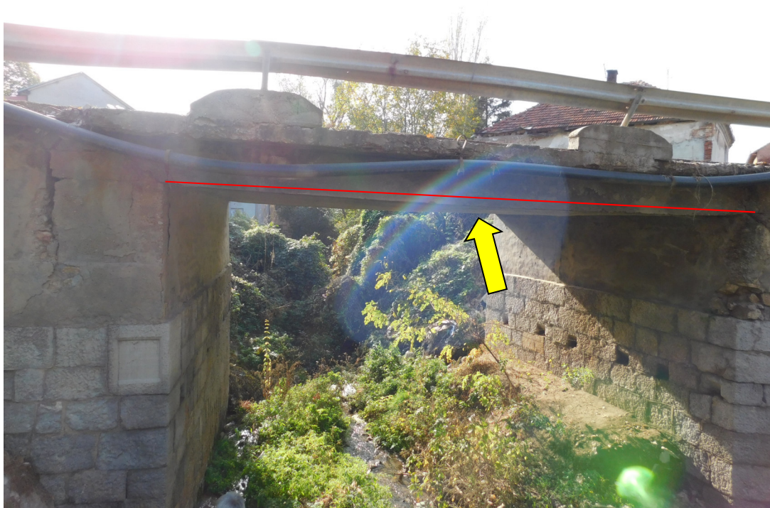
Слика 09: Поглед са узводне стране. Видан угиб плоче у средини распона.
