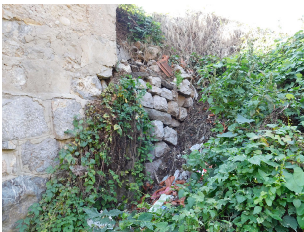
Слика 10: Поглед са узводне стране, стубови на страни ка Кнез Селу (слика лево) и ка Нишу (слика десно). Кегле су оштећене, запуштене и обрасле вегетацијом.
