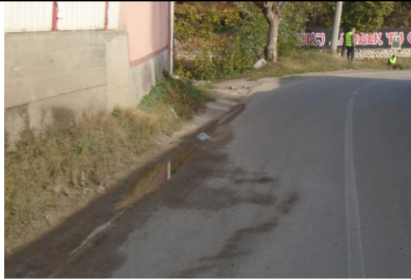
Слика 5 – Задржавање воде са коловоза на деоници испред моста
