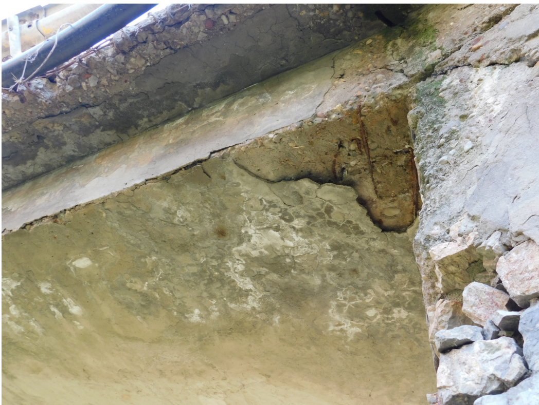
Слика 02: Поглед са узводне стране на коловозну плочу и стуб на страни ка Нишу. Заштитни слој је делимично пропао, арматура је кородирала и видљиво је процуривање воде са коловоза, као и калцификација бетона.
