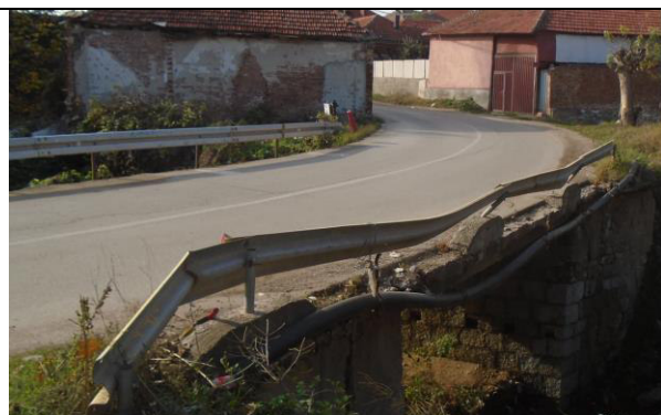
Слика 9 – Непостојање пешачких ограда на постојећем мосту
