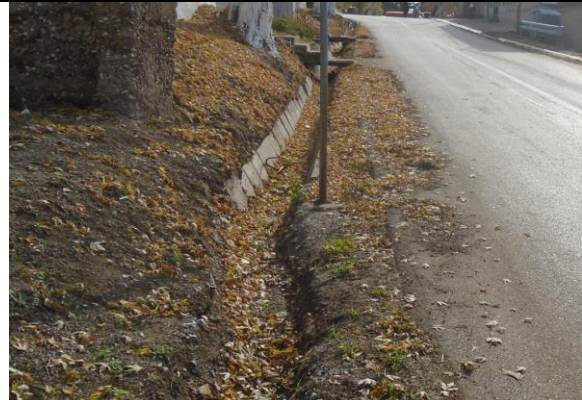
Слика 6 – Нерешено одводњавање прибрежне воде
