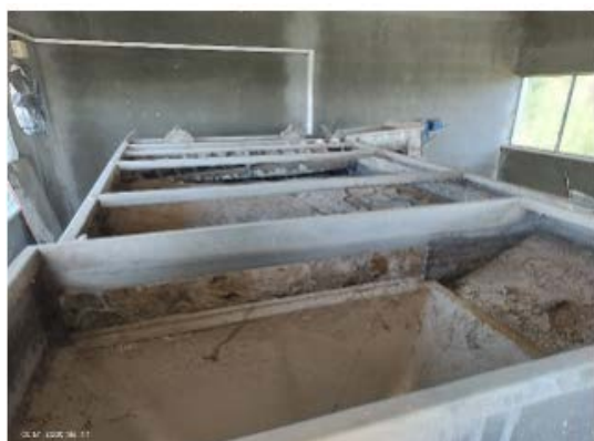
Слика 2. Песколов/мастолов ван функције (лево) и анаеробни базен за БИО Р (десно)
