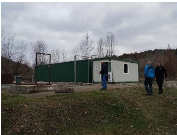
Слика 19. ППОВ Трговиште, SBR 2 x 900EC (лево) и прелив из шахта испред ППОВ-а (десно)
