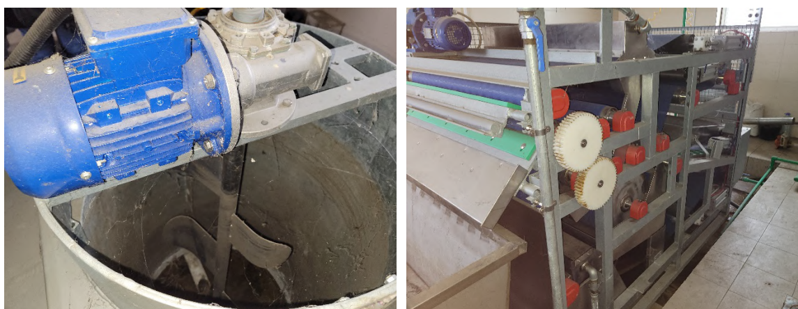
Слика 4. Тракаста филтер преса
