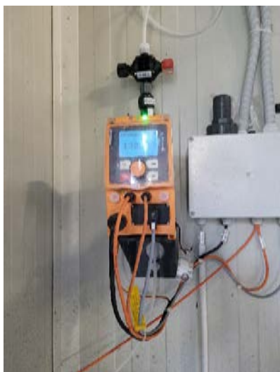
Слике 7. ППОВ Барајево дозирна пумпа и простор за уградњу резервоара фери-хлорида
