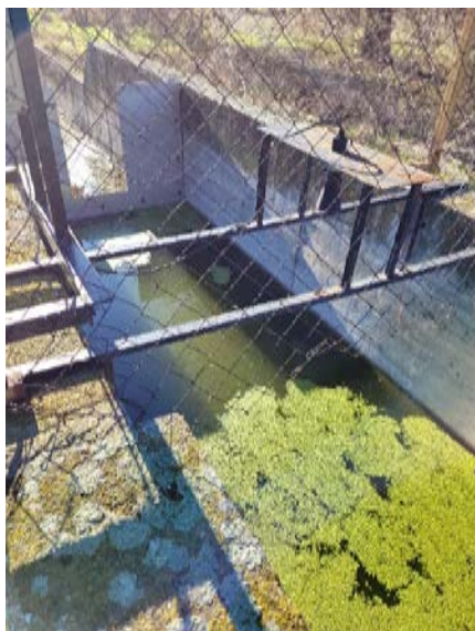
Слике 11. ППОВ Кикинда мерач протока на излазу из постројења
