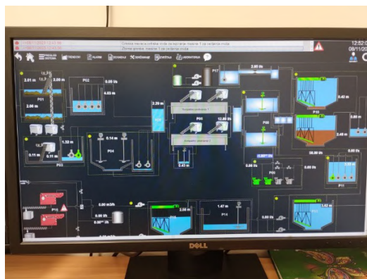
Слика 6. ППОВ Рашка дуваљке и SCADA
