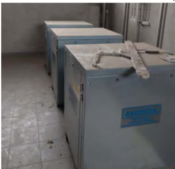
Слика 3. Дувалке за SBR базен (лево) и центрифугални декантер (десно)
