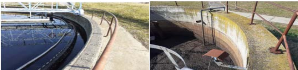
Слика 7. Изглед ободног канала финалног таложника (лево) и базена за муљ (десно)
