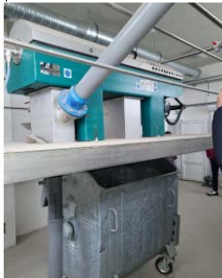
Слика 3. Дувалке за SBR базен (лево) и центрифугални декантер (десно)
