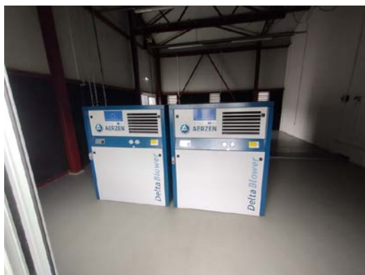
Слика 6. ППОВ Рашка дуваљке и SCADA
