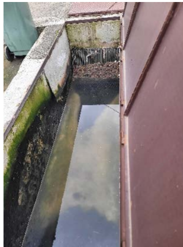
Слика 3. Егализациони базен (лево) и гравитациони песколлов/мастолов (десно)
