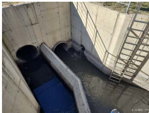
Слика 1. Улазне fine решетке (лево) и улазна грађевина (десно)
