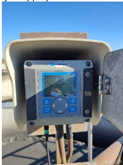
Слика 5. Анаеробни базен у другом биолошком базену ван функције (лево) и трансмитер on-line мерења на биолошком базену (десно)
