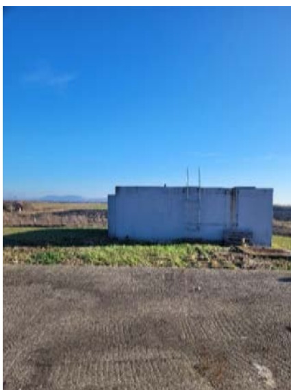
Слике 7. ППОВ Пландиште резервоар и дубаљка за аеробну стабилизацију муља
