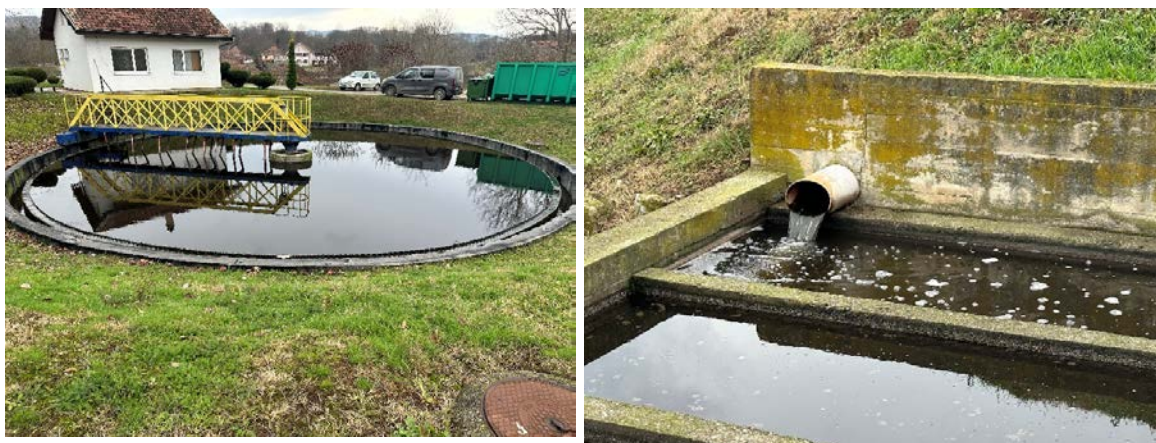
Слика 43. Финални таложник (ево) и излазна пречишћена вода (десно)
