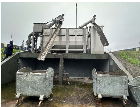
Слика 18. Дисплеј улазног мерача протока (лево) и Комбиновани уређај механичког предтретмана (десно)
