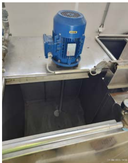
Слика 4. Филтер преса (лево) и комора јединице за припрему полиелектролита (десно)
