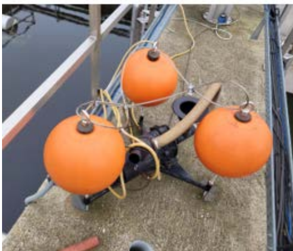
Слика 2. Плућајуће пумпе за надмуљну воду у резервоару за стабилизацију муља (лево) и SBR базен (десно)
