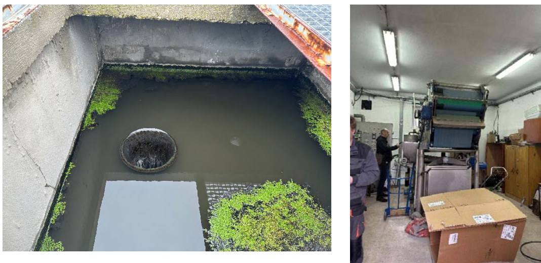
Слике 4. ППОВ Пећинци излазна пречишћена вода и филтер преса која није у употреби од 2009. године
