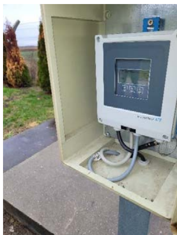
Слика 18. Дисплеј улазног мерача протока (лево) и Комбиновани уређај механичког предтретмана (десно)
