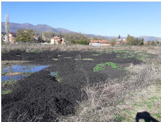
Слика 2. ППОВ Врање неусловно одлагање муља у кругу постројења
