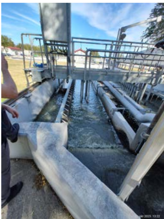
Слика 2. Аерисани песколлов-мастолов (лево) и базен за пре-денитрификацију (десно)
