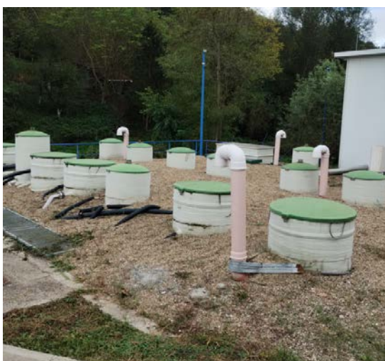
Слика 2. Електрокоагулација за уклањање фосфора и стабилизација муља (лево) и SBR базени урађени у фазама (десно)
