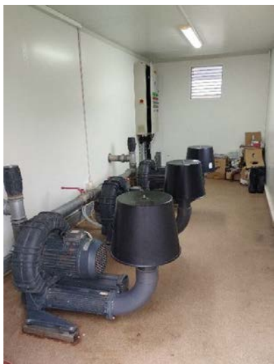
Слика 4. Дуваљке SBR базена (лево) и Систем за дозирање раствора Натријум хипохлорита (десно)
