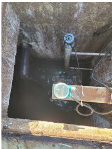
Слике 3. ППОВ Пландиште егализација са сондом за мерење нивоа
