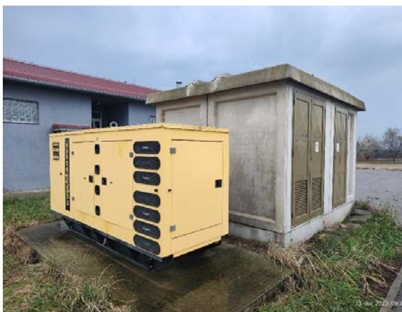
Слика 21. Трафо станица и Дизел агрегат
