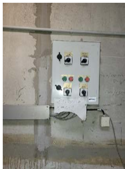
Слике 6. ППОВ Степановићево електро орман дуваљки са наТПисом „неисправно-не укључуј“
