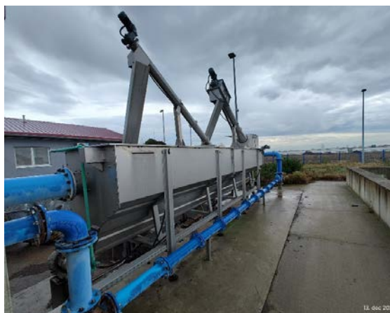
Слика2. Комбиновани уређај за механички третман и масолов/песколов
