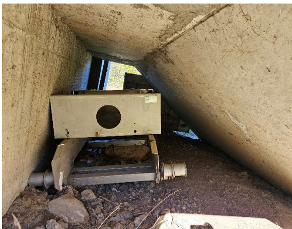
Слике 3. ППОВ Горњи Милановац демантирана нова фина решетка уграђена неадекватно приликом реконструкције 2016. и онемогућавала је проток воде кроз потројење, и решено је тако што је демантирана
