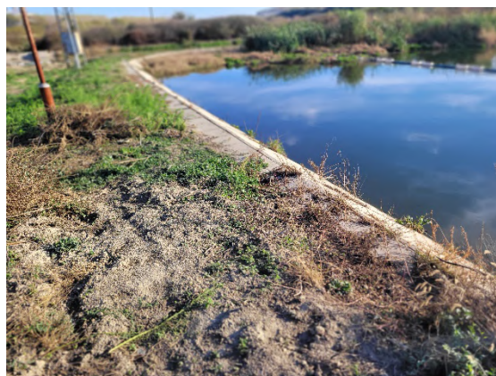
Слике 4. ППОВ Бач биологуне - нефункционалне
