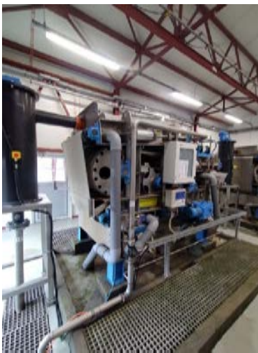
Слика 5. ППОВ Рашка обезводњавање муља
