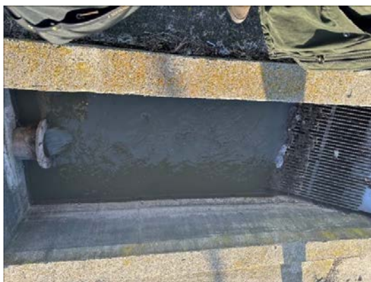
Слике 2. ППОВ Пландиште улазна пумпна станица са by-pass -ом и грубом решетком-корпом
