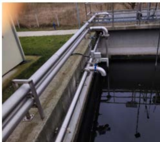
Слика 2. Плућајуће пумпе за надмуљну воду у резервоару за стабилизацију муља (лево) и SBR базен (десно)
