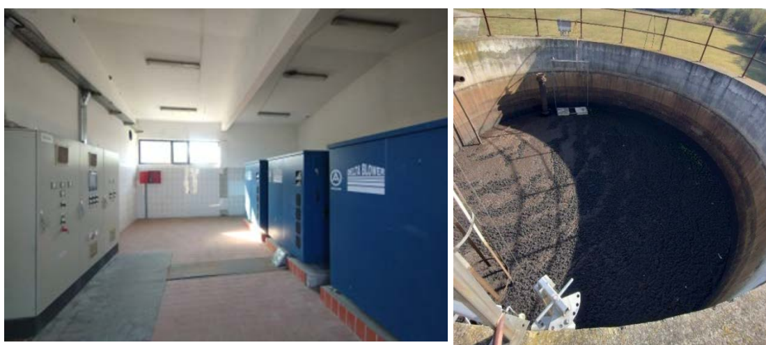
Слика 25. Објекат дувалњи за аерацију (лево) и муљ у гравитационом угушћивачу (десно)
