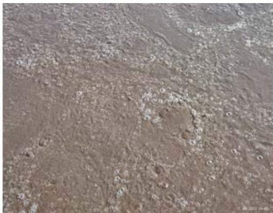
Слика 3. Активни муљ у N/DN базену (лево) и накнадни таложник – преливна ивица (десно)
