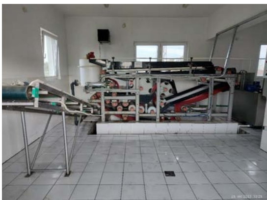
Слика 7. Обезводњавање муља (филтер преса са интегрисаним предугушћивачем)
