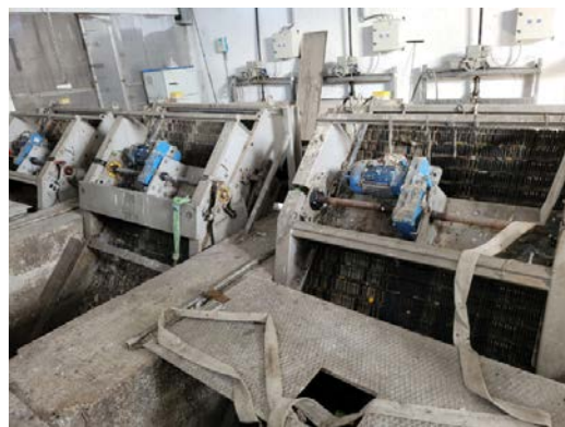
Слика 1. Механички предтретман – Груба решетка ручна (лево) и аутоматске fine решетке (десно)
