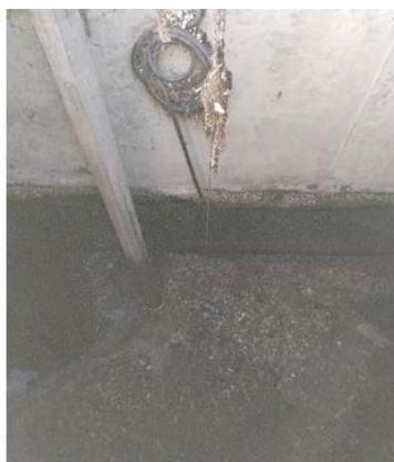
Слика 3. Егализациони базен ултразвучно мерење нивоа и нагомилан муљ
