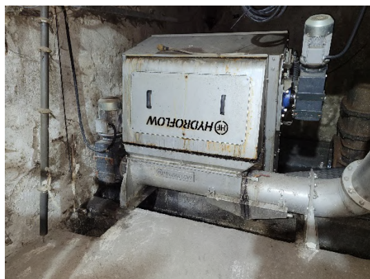
Слике 39. ППОВ Кикинда улазни затварач (неисправан, за замену) и улазна груба решетка, функционална
