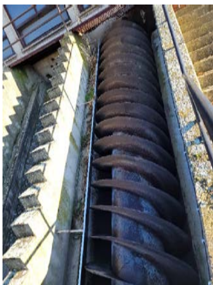
Слике 9. ППОВ Кикинда пужне пумпе за рецикулацију и вишак муља – ван функције
