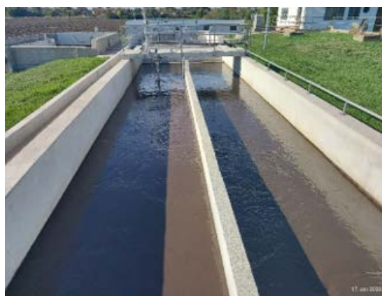
Слика 2. Песколов/мастолов ван функције (лево) и анаеробни базен за БИО Р (десно)
