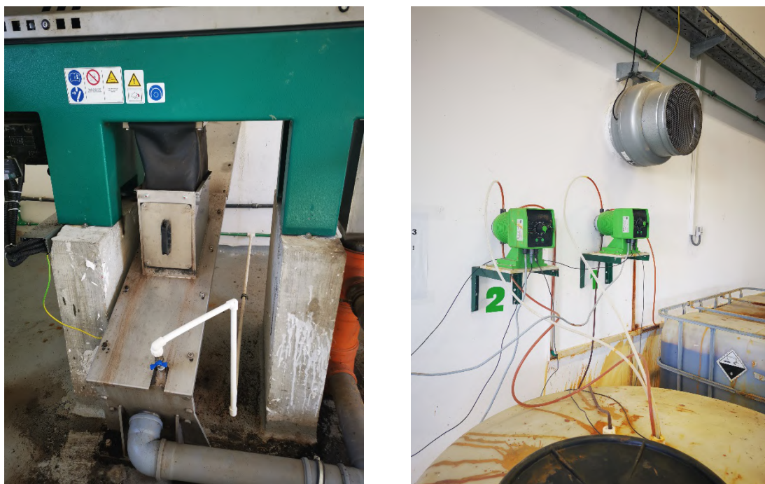
Слика 12. Центрифуга (лево) и Пумпе за дозирање ферихлорида (десно)
