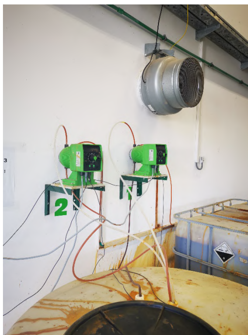
Слика 7. Центрифуга (лево) и Пумпе за дозирање ферихлорида (десно)
