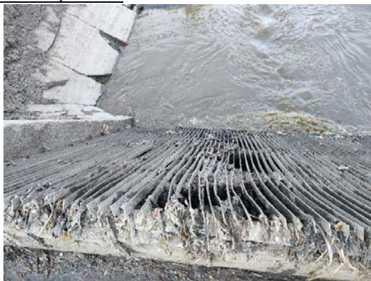
Слика 1. Механички предтретман – Груба решетка ручна (лево) и аутоматске fine решетке (десно)
