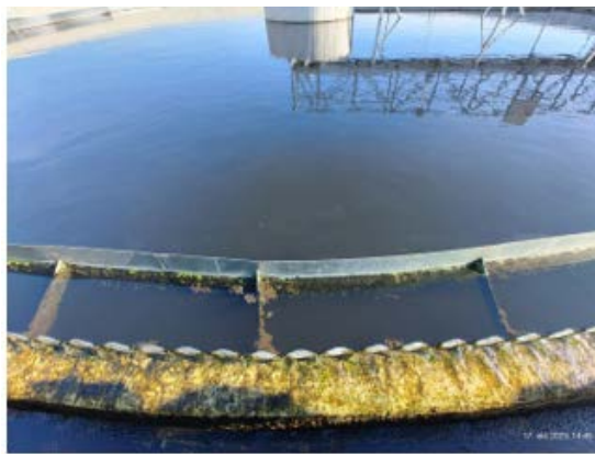
Слика 3. Активни муљ у N/DN базену (лево) и накнадни таложник – преливна ивица (десно)
