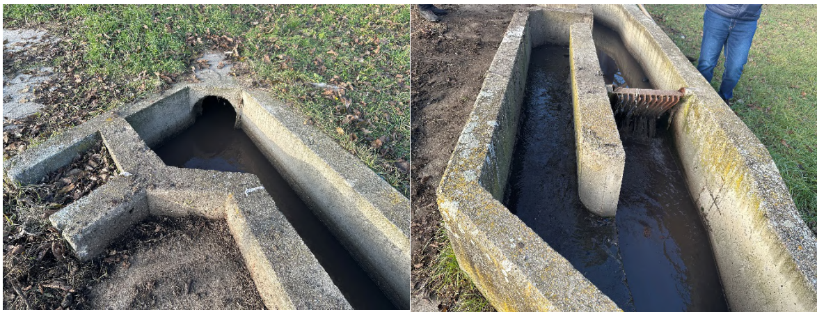
Слике 37. ППОВ Стара Моравица улаз отпадне воде и груба решетка и песколлов
