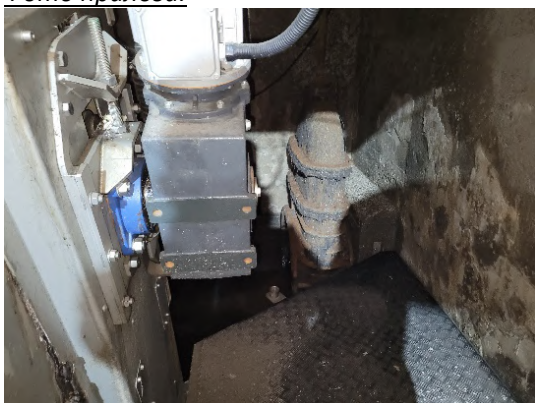
Слике 39. ППОВ Кикинда улазни затварач (неисправан, за замену) и улазна груба решетка, функционална
