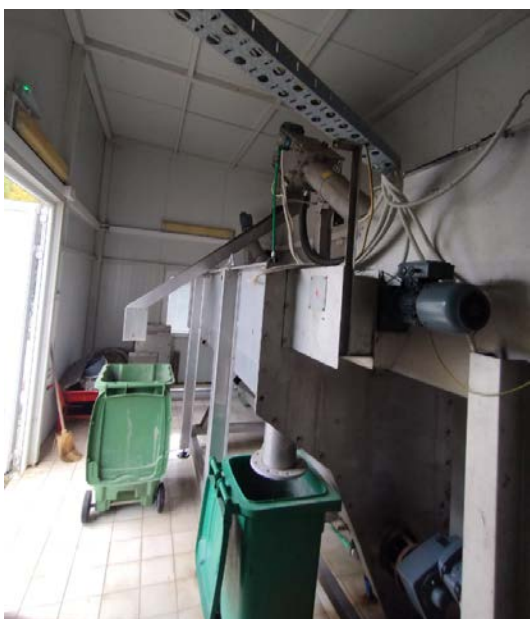
Слика 1. Комбиновани компактни уређај за механички предtretман (лево) и изглед ППОВ (десно)
