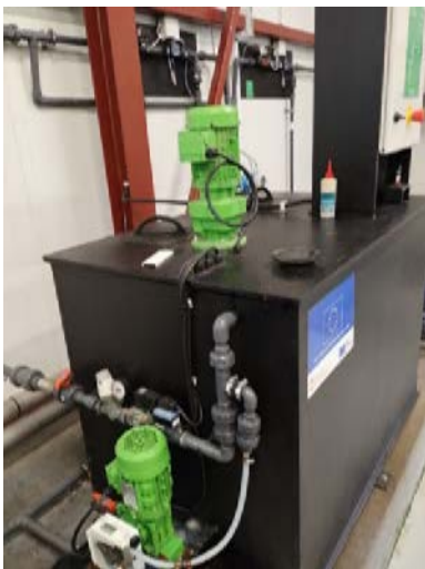
Слика 5. ППОВ Рашка обезводњавање муља
