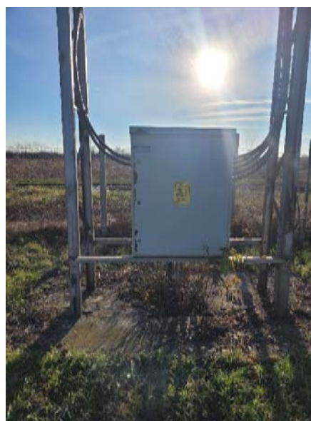
Слика 10. ППОВ Пландиште стубна трафо станица
