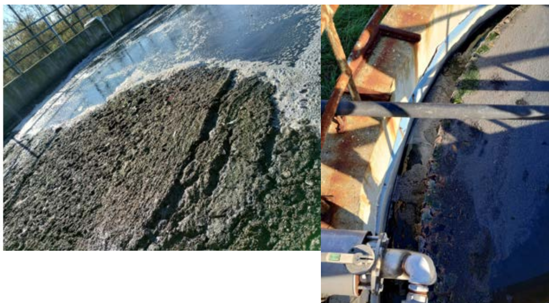
Слика 5. Муљ нагомилан у аерационом базену (лево) и канал пречишћене воде финални таложник (десно)
