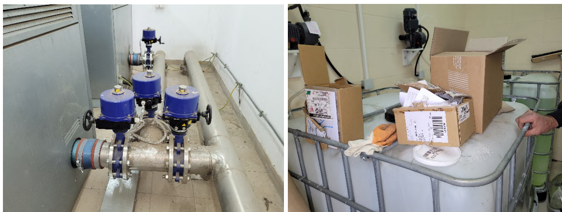
Слика 5. Компресорска станица дувалке (лево) и опрема за дозирање воденог раствора Натријум хипохлорита (десно)
