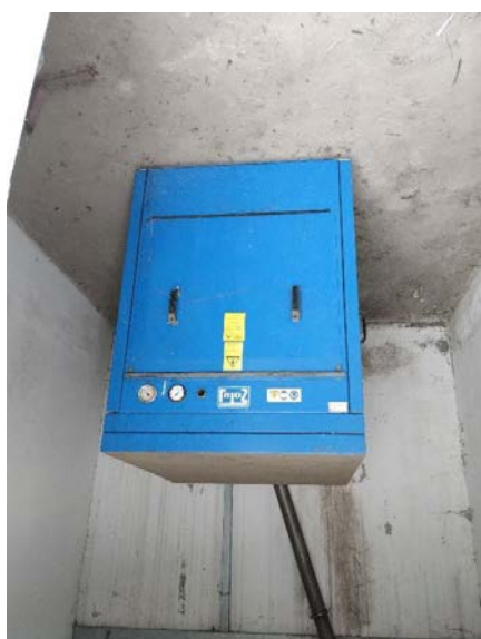
Слика 6. Дуваљка за SBR базен (лево) и танк и пумпа за дозирање раствора фери-хлорида (десно)
