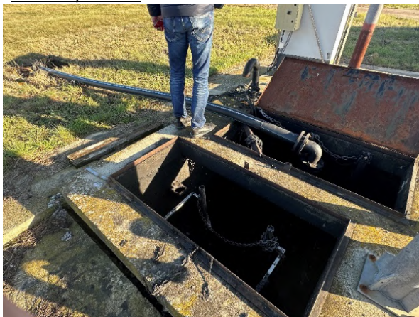
Слике 38. ППОВ Пландиште улазна пумпна станица са by-pass -ом и грубом решетком-корпом
