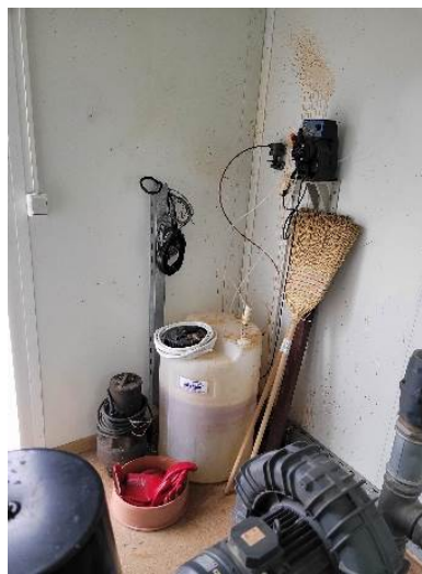
Слика 4. Дуваљке SBR базена (лево) и Систем за дозирање раствора Натријум хипохлорита (десно)
