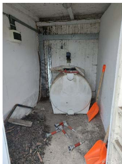
Слика 6. Дуваљка за SBR базен (лево) и танк и пумпа за дозирање раствора фери-хлорида (десно)
