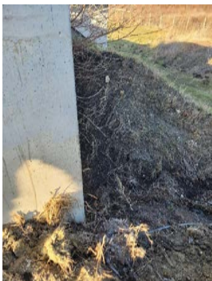
Слике 8. ППОВ Пландиште оштећен насип и хидрантски ормарић
