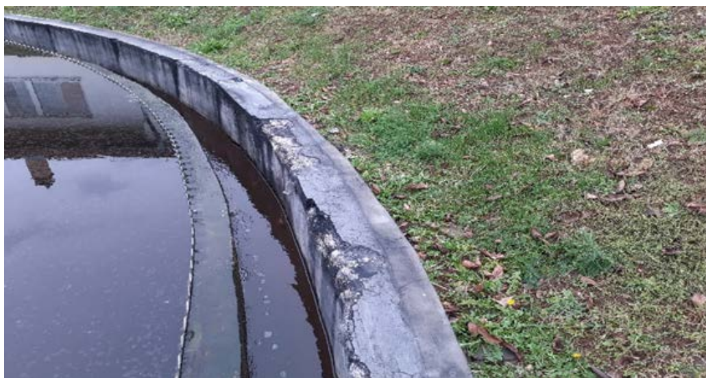
Слика 44. Ободни канал финалног таложника- изглед бетона
