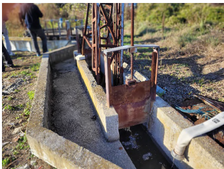
Слике 3. ППОВ Бач песколов – ван функције
