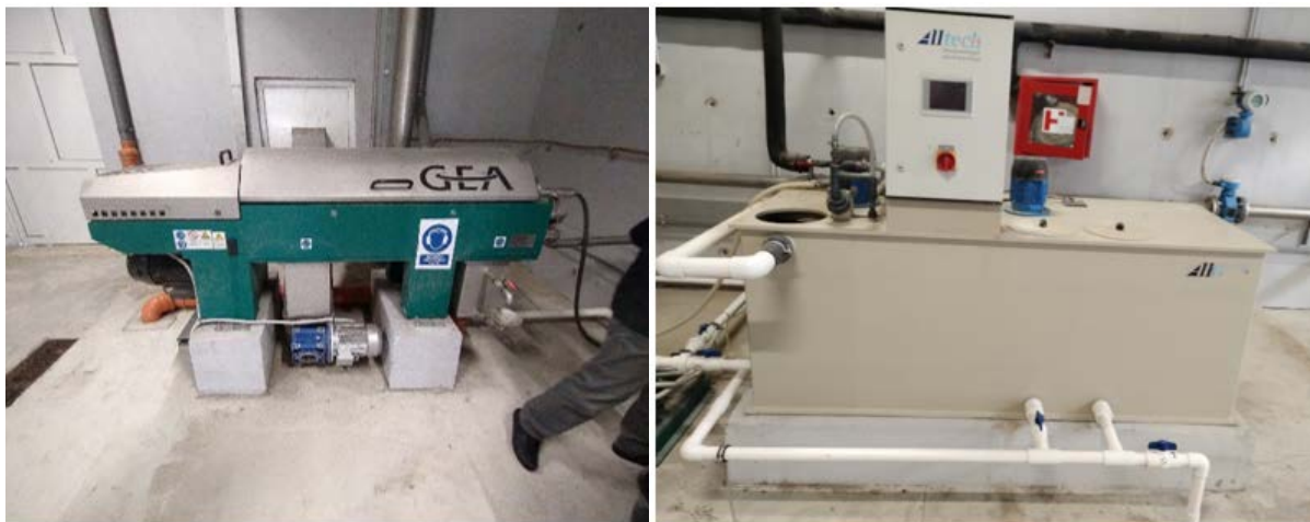
Слика 6. Центрифугални декантер (лево) и јединица за припрему полиелектролита (десно)
