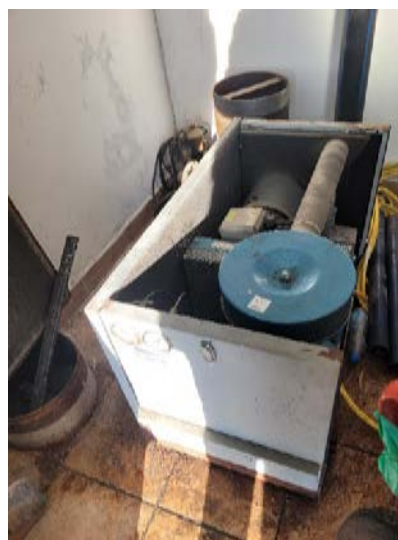
Слике 7. ППОВ Пландиште резервоар и дубаљка за аеробну стабилизацију муља
