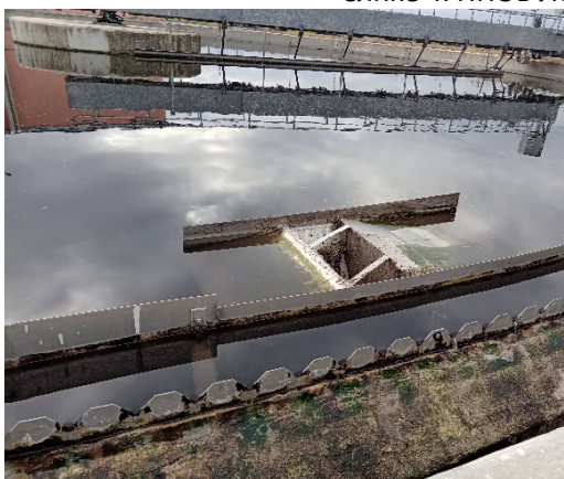
Слике 5. ППОВ Лесковац финални таложник и обезводњавање муља
