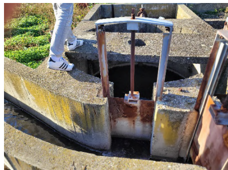
Слике 3. ППОВ Бач песколов – ван функције
