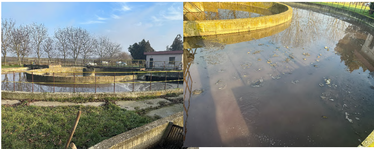
Слике 2. ППОВ Стара Моравица биолошки базен са финалним таложником напуњен смећем
