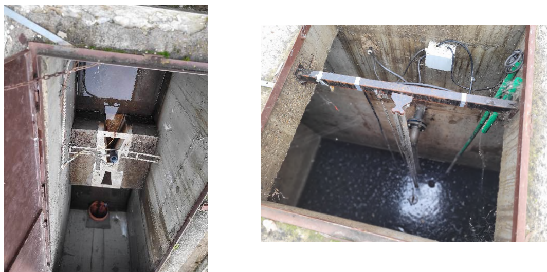
Слика 7. Излазни мерач протока и место дозирања дезинфикационог средства (лево) и резервоар вишка муља са препумпном станицом (десно)
