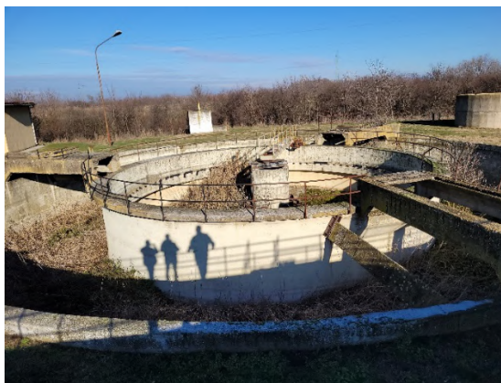
Слике 6. ППОВ Кикинда биоаерација са финалним таложником, напуштена
