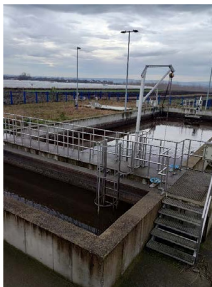
Слика 4. SBR реактор
