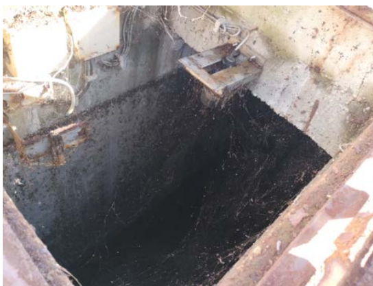
Слика 3. Егализациони базен ултразвучно мерење нивоа и нагомилан муљ
