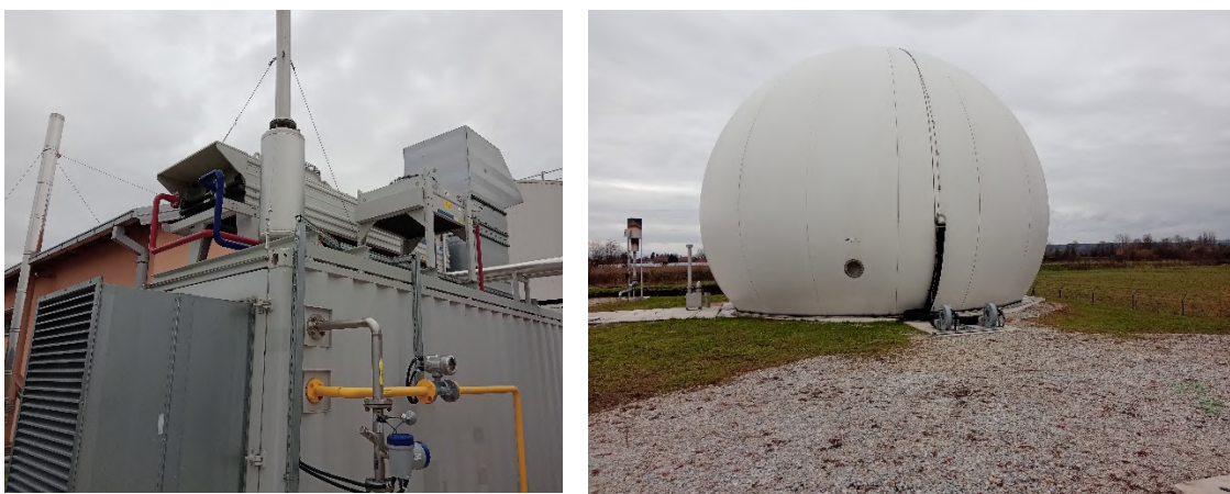
Слике 8. ППОВ Лесковац гасни мотор и резервоар биогаса
