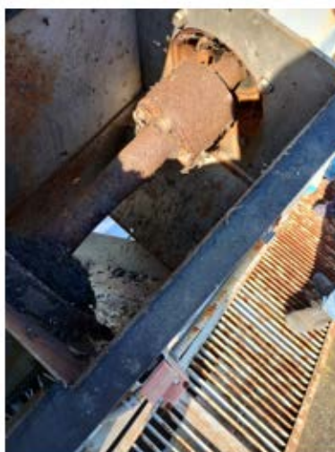
Слика 2. Комбиновани уређај за механички предтретман осовина пужа
