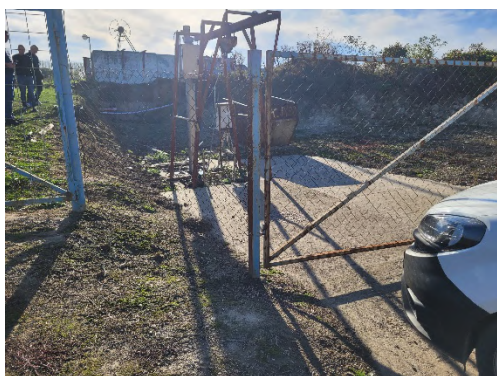
Слике 32. ППОВ Бач улазно сито – ван функције
