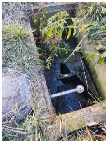
Слике 7. ППОВ Степановићево излазни мерач протока, узоркивач
