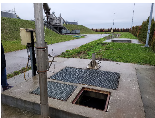
Слика 17. Улазна црпна станица (лево) и шахт са мерачом протока (десно)
