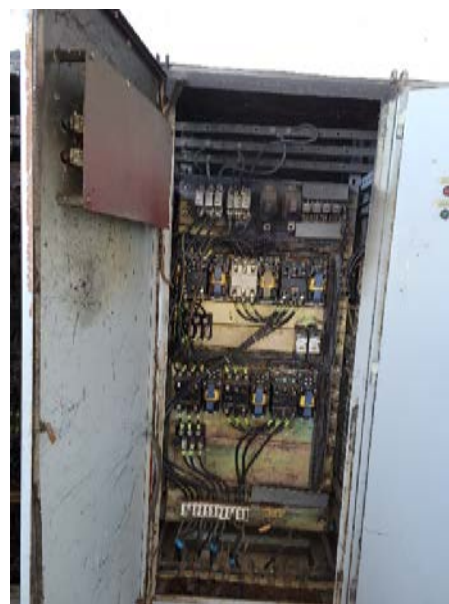
Слике 10. ППОВ Кикинда део уништених електроормана за напајање постројења ел. енергијом
