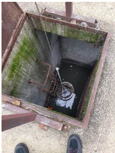
Слика 20. Груба решетка-корпа (лево) и улазна црпна станица (десно)
