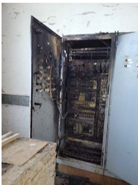
Слике 10. ППОВ Кикинда део уништених електроормана за напајање постројења ел. енергијом
