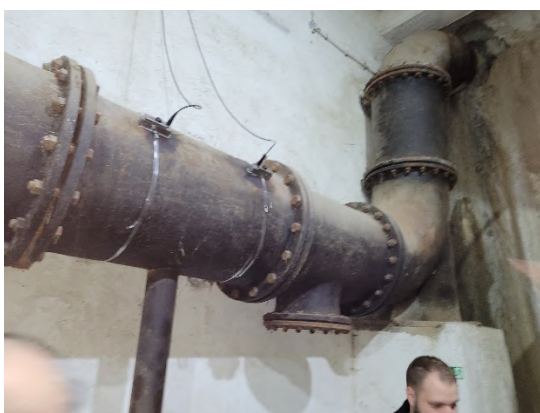
Слике 3. ППОВ Кикинда улазни мерач протока
