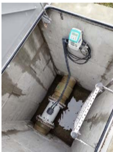
Слике 2. ППОВ Рашка компензациони и мерење протока
