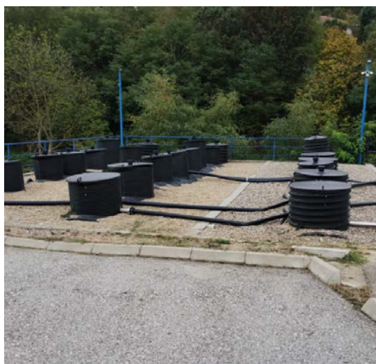
Слика 2. Електрокоагулација за уклањање фосфора и стабилизација муља (лево) и SBR базени урађени у фазама (десно)
