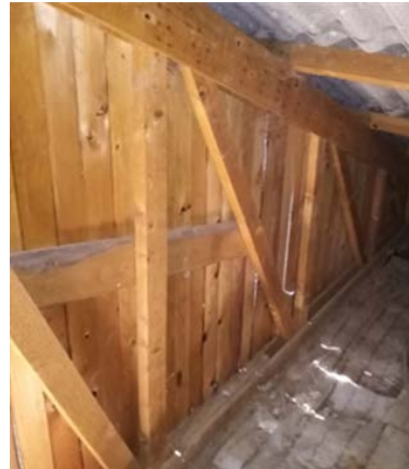
Дрвени решеткасти кровни везачи са кровним покривачем од трапезастог лима и салонита
